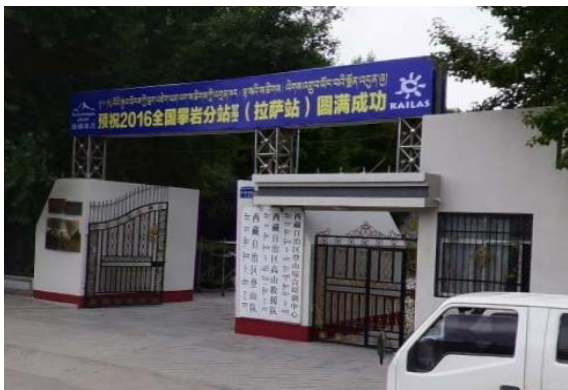
项目西北面西藏自治区登山学校
