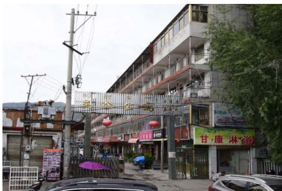
项目西北面吴涂公寓
