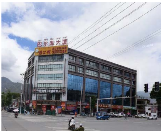
项目东北面巴尔库大厦
