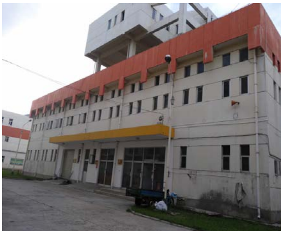
项目原材料库及前处理车间
