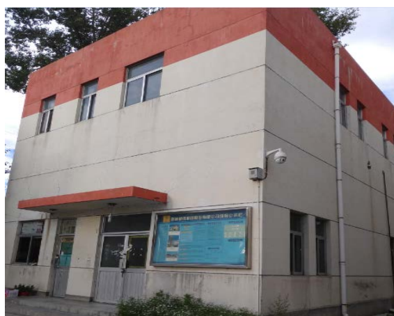
污水处理站配套用房
